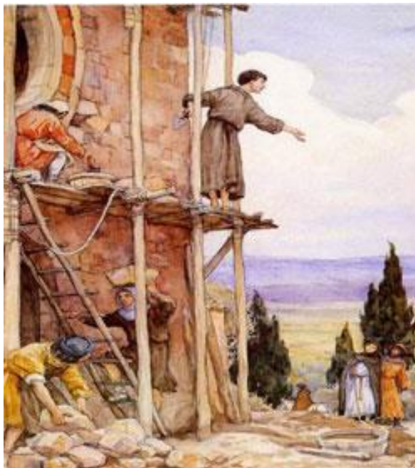
San Francisco de Asís reparando Iglesia
